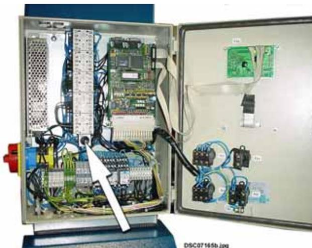
Bild 2: Position des Überbrückungsschalter
