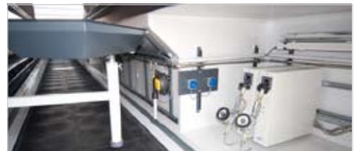
Système d'évacuation d'huile et de graisses
