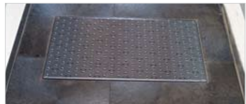
Fosse à huile avec couvercle antidérapant
